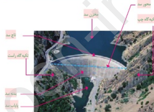
شکل ۱۸-۶: نمای از بخش‌های مختلف یک سد
