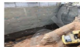
ب) دیوار صخ کوبی شده
