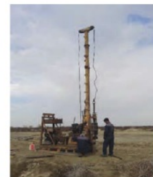
شکل ۳-۴ حفاری گمانه اکتشافی توسط دستگاه حفاری
