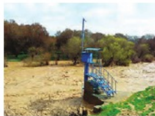
شکل ۲-۳. ایستگاه اندازه گیری آبدهی رود
