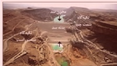
شکل ۴-۵: نمایی از بخش‌های مختلف یک سد
