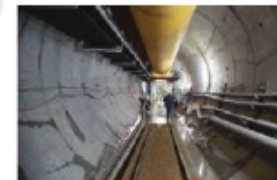
ب) پوشش‌های بتنی در مترو
