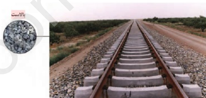
شکل ۶-۲۳. بالاست استفاده‌شده در زیرسازی جاده ریلی
