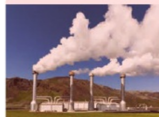
شکل ۶-۱۱- نیروگاه زمین گرمایی مشکین شهر- اردبیل
