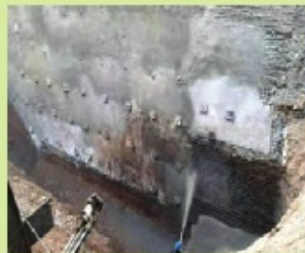
پایدارسازی شیب به روش میخ کوبی
