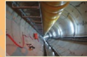
تونل انتقال آب (تونل گلی سب - بیرانشهر)
