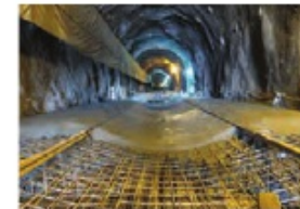
ب) نحوه اجرای پوشش‌های بتنی در فضاهای زیرزمینی
